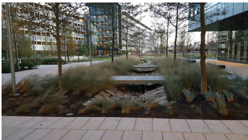
รูปที่ 18 สวนรับน้ำฝน (rain garden) และทางเดินผิวลาดแข็งที่น้ำซึมได้
