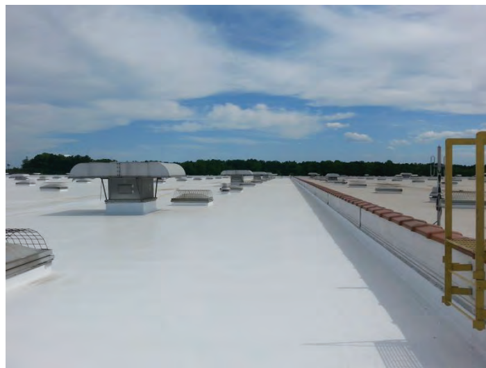
รูปที่ 36 การใช้ ceramic coating ทาบนหลังคา
