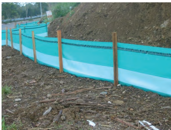
รูปที่ 92 การป้องกันตะกอนดินไหลออกนอกพื้นที่
