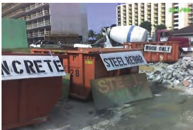
รูปที่ 93 การคัดแยกขยะในสถานที่ก่อสร้าง
