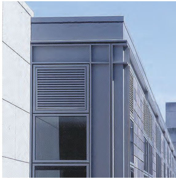
รูปที่ 66 ตัวอย่างตำแหน่งช่องนำอากาศภายนอกเข้า (air intake)
