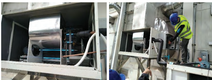
รูปที่ 63 การติดตั้งระบบ UVGI ใน AHU
