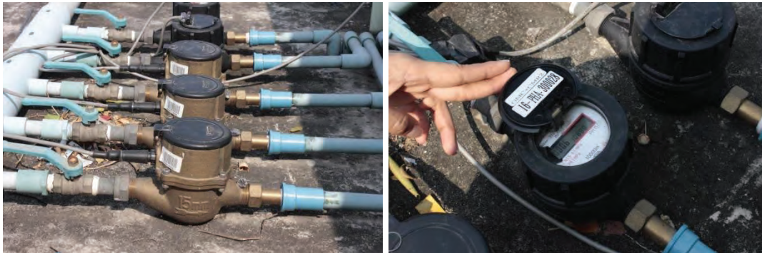
รูปที่ 85 ตัวอย่างการติดตั้งมาตรวัดน้ำย่อยแบบ digital แยกการใช้น้ำรายประเภท
